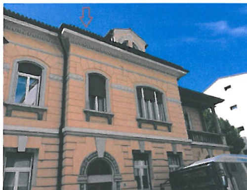
Falda lato strada con 3 lucernari
