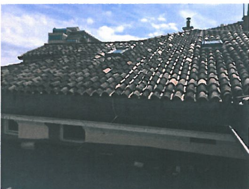
Lucernari lato terrazzino
